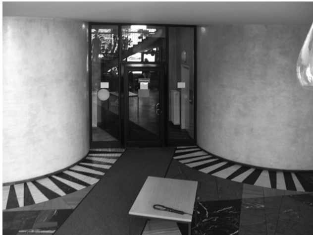
Zustand vor der Sanierung
