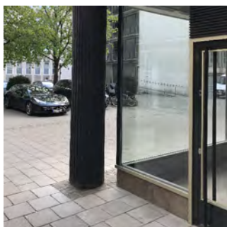
Glasecke der Pfosten-Riegelfassade
