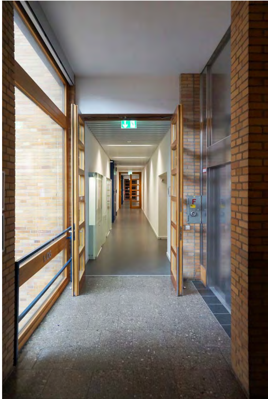
Flur nach Brandschutzertüchtigung
